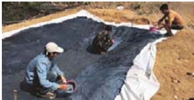
พนักงานไทยเบฟร่วมกันทำบ่อเลี้ยงปลา (ปูฟาดับเคลื่อนย้ายฟารพสม เพื่อป้องกันน้ำซึม) เพื่อโครงการอาหารกลางวันของนักเรียนโรงเรียนบ้านศรีศรีรักษ์
